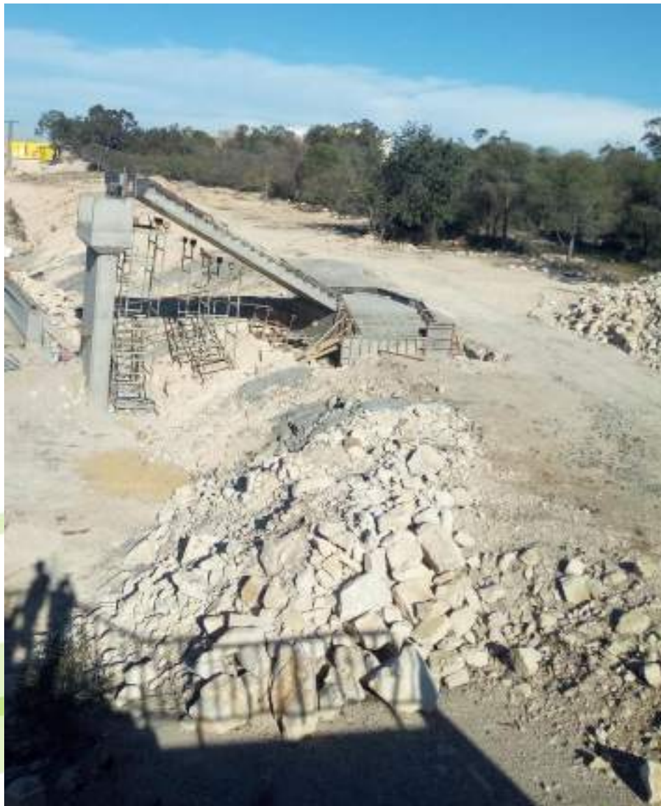
Passerelle en cours d'exécution en face du parc
